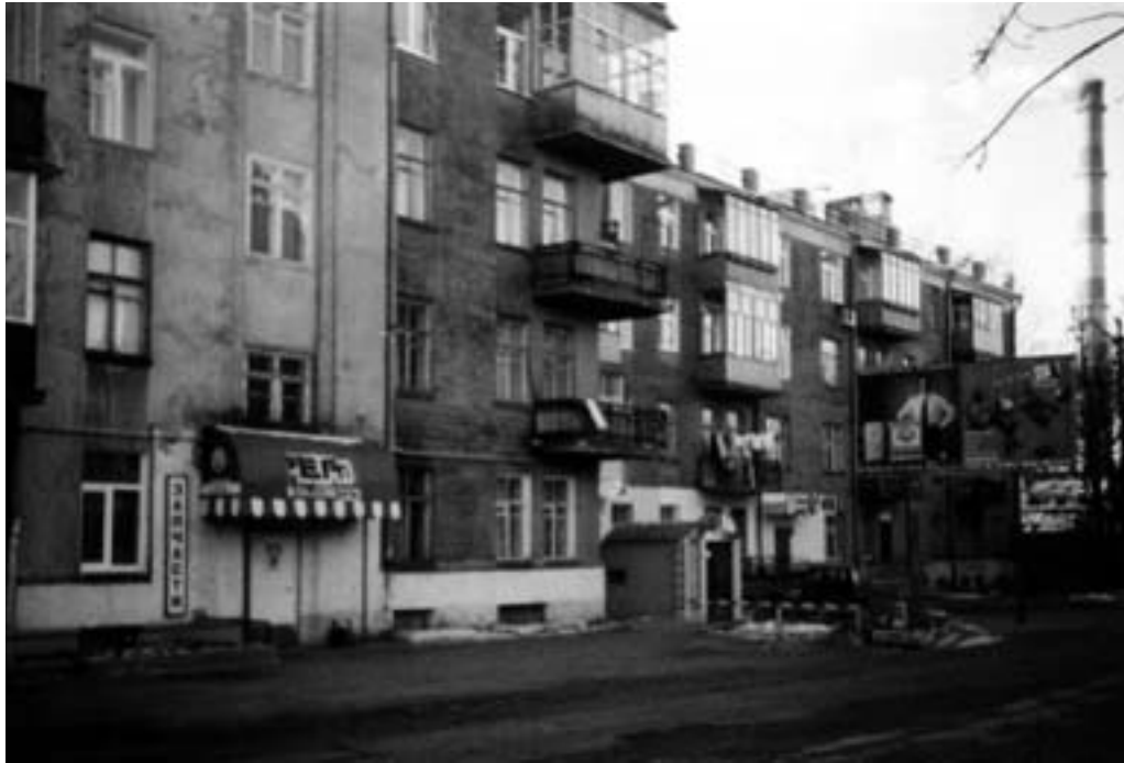
Foto 9: Ivanovo – Sanierung im Erdgeschoss / Street-level adaptation. © Sergei Sitar.
