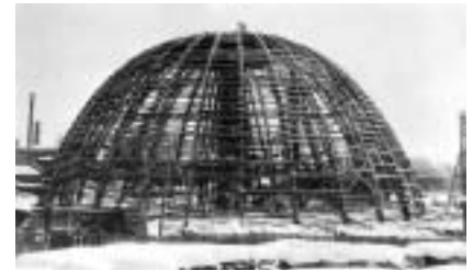
Строительство деревянного купола цирка. Cupola of the circus under construction. 1931
